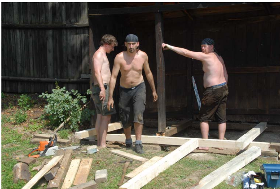
Výměna vazných trámů roštové konstrukce kabin
