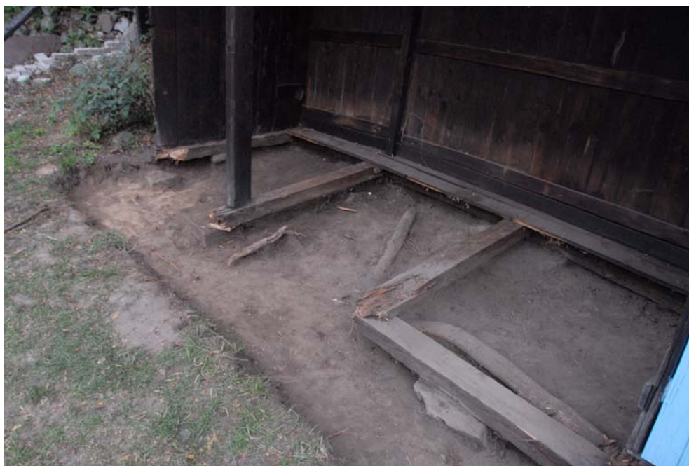
Uhnílé trámy roštové konstrukce byly nahrazeny
