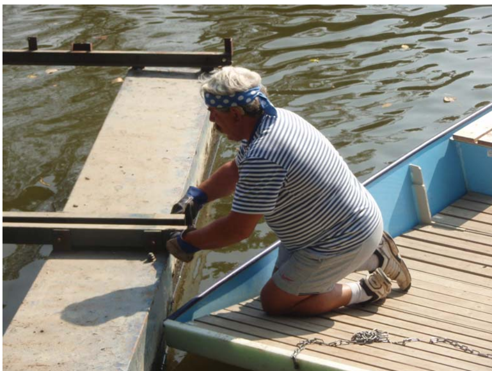
Těsné spojení pontonů
