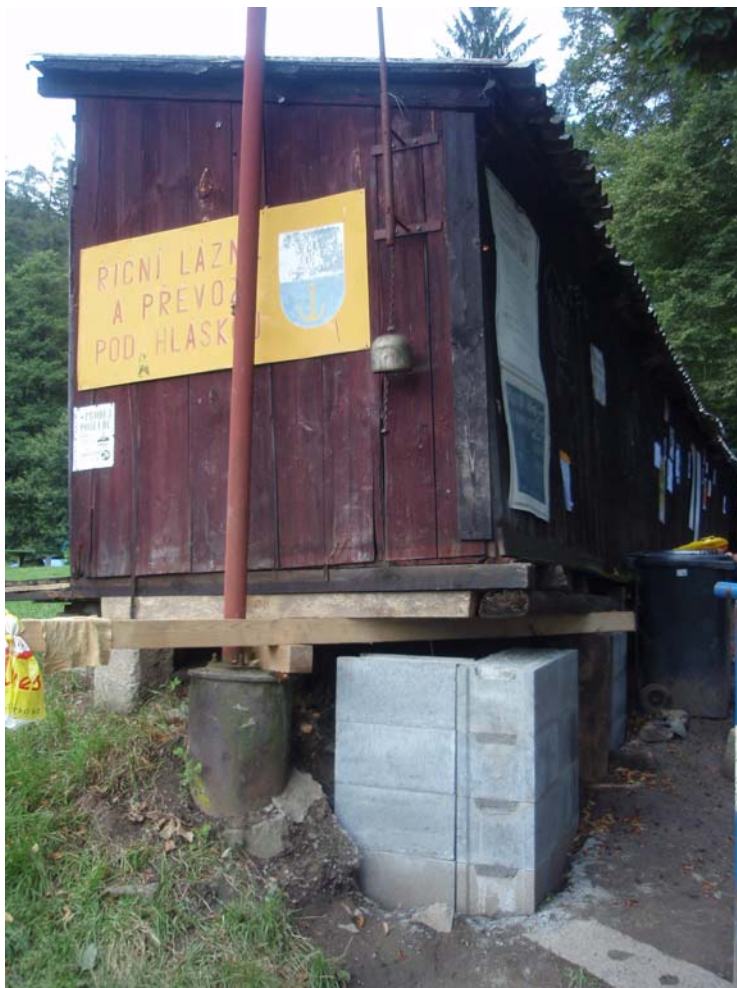
Před spuštěním kabin na novou konstrukci nároží
