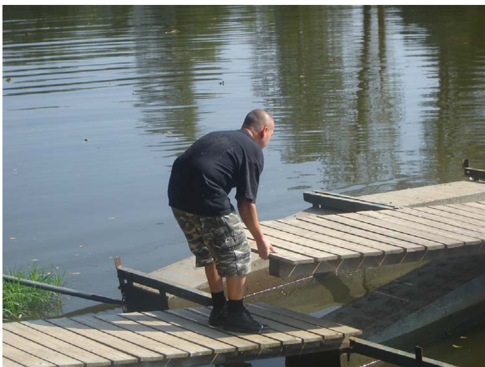
Položení podlažek na konstrukci pontonu
