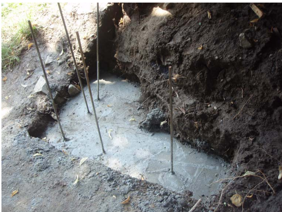
Betonování a armování základů
