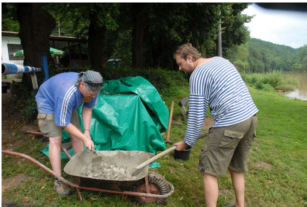
Ruční míchání betonu na stavbu
