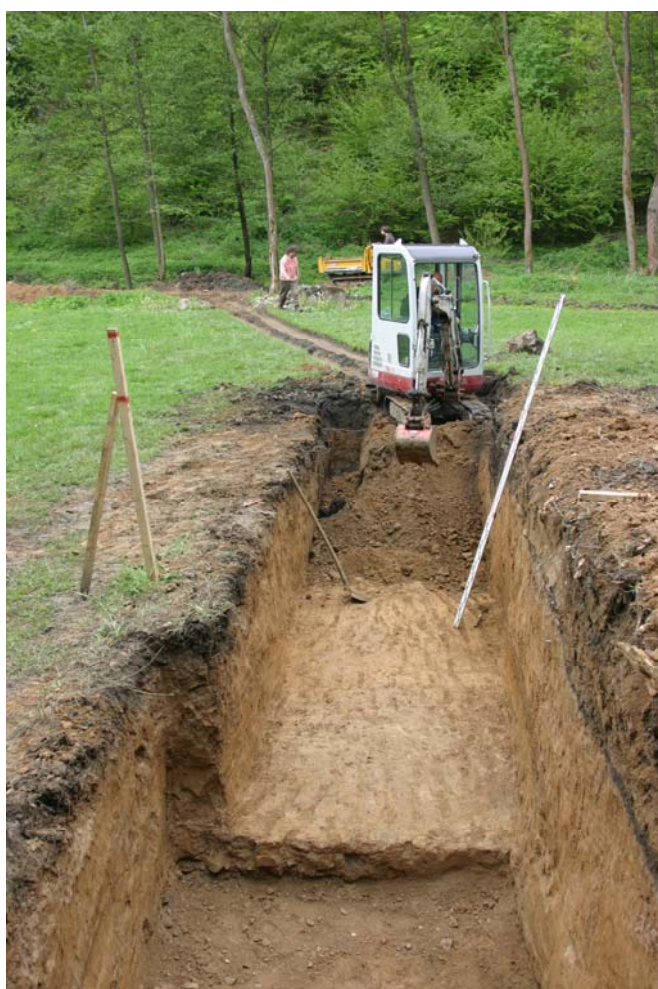
Rozsáhlá stavební jáma jímky a zemního filtru (vzadu)
