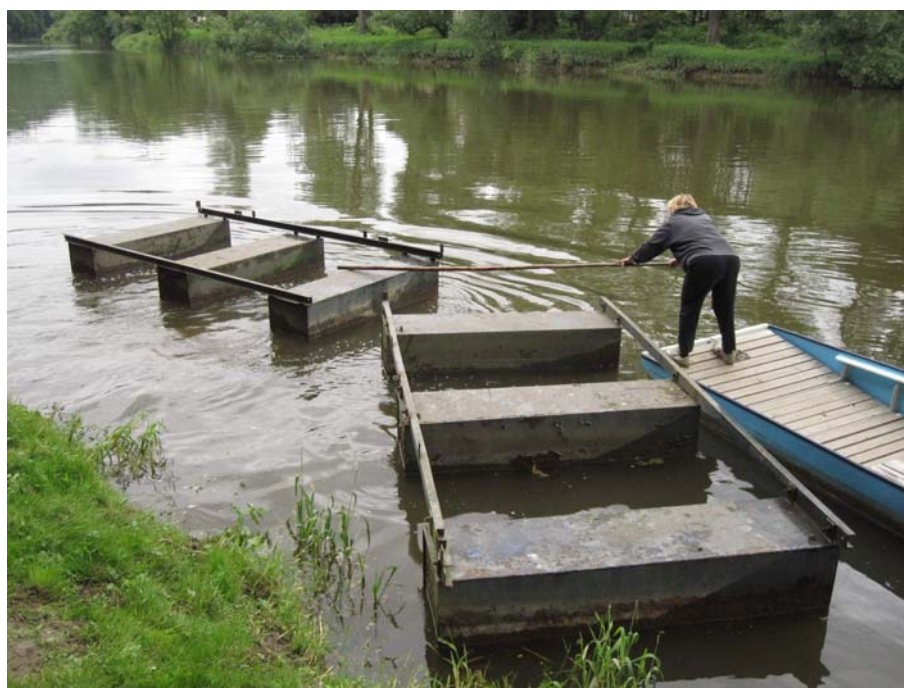
Postupné sestavení pontonu již na vodě
