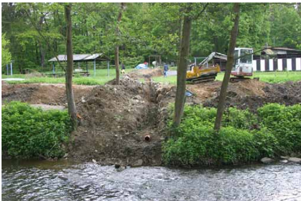
Vyústění kanalizačního řadu do Mnichovky
