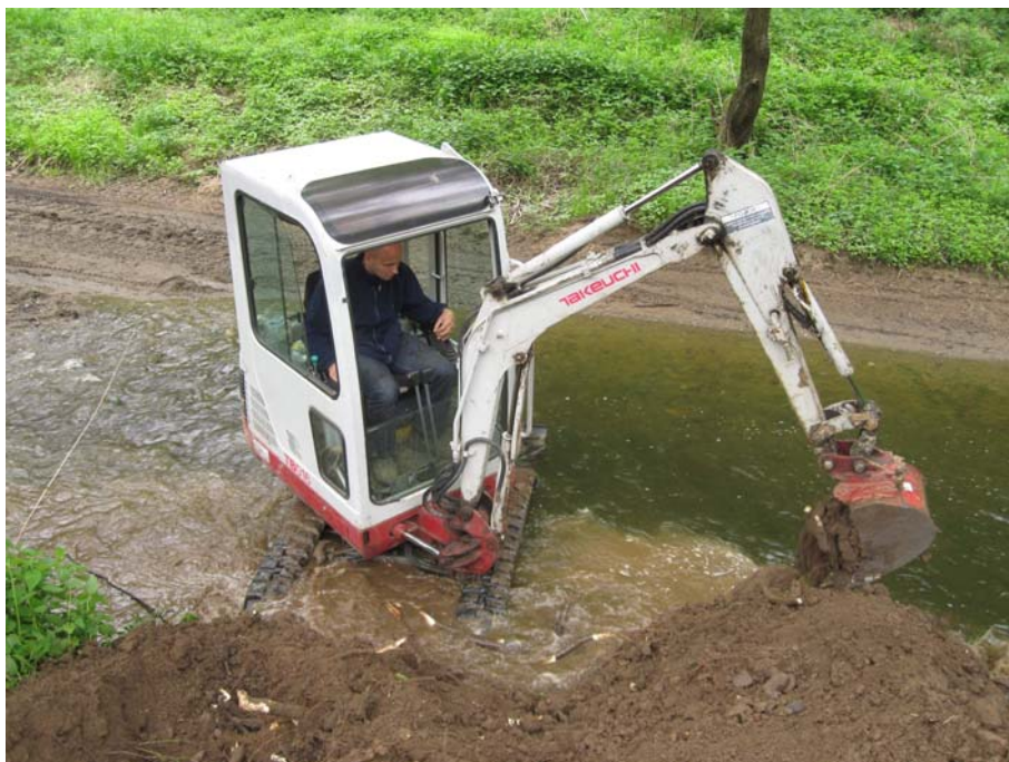
Úprava vyústění kanalizace do potoka Mnichovky
