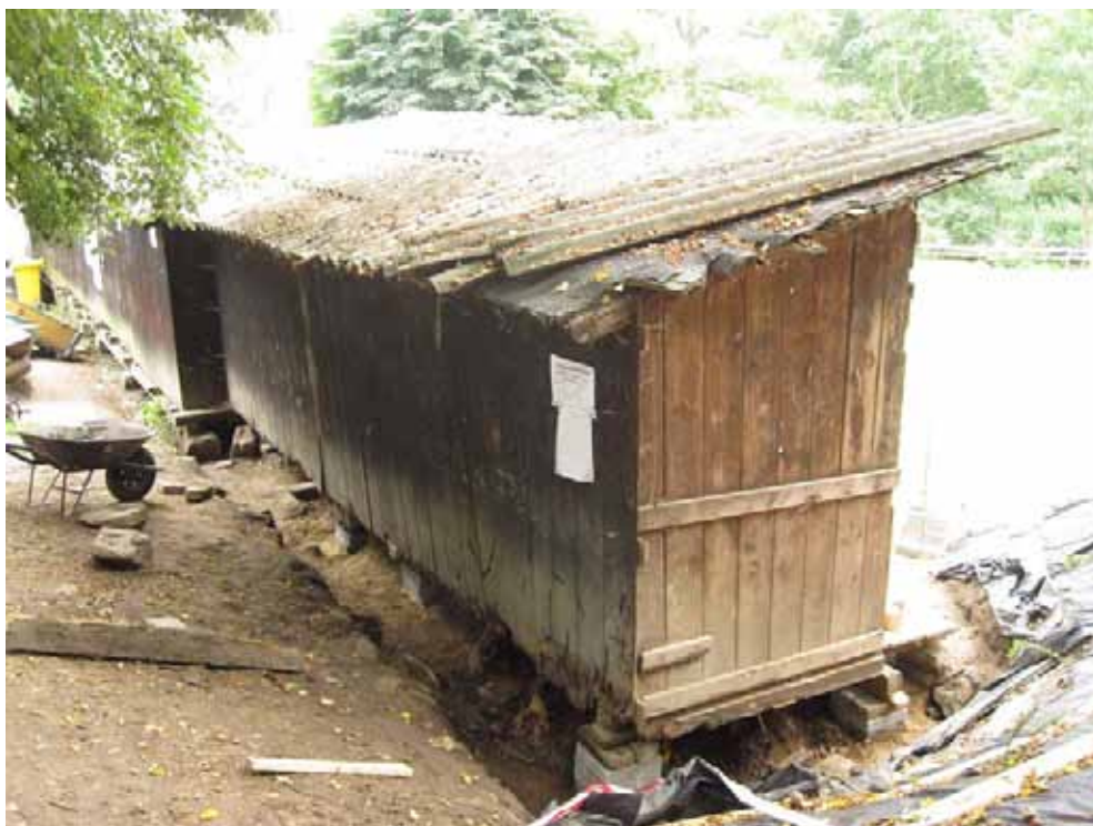
Kabiny jsou podezděny
