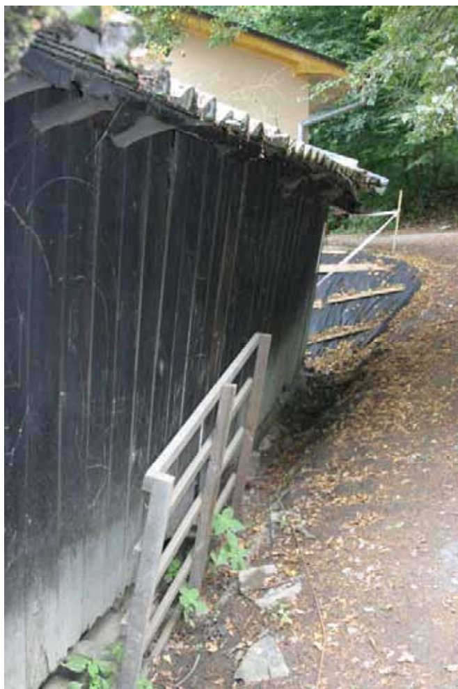
Vyhnutá zadní stěna kabin před opravou
