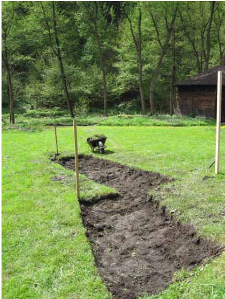
Před zahájením výkopových prací jsme náročně sejmuli drn v místech projektovaných zemních zásahů
