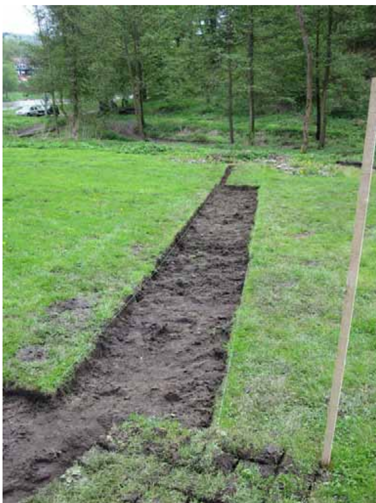
Před zahájením výkopových prací jsme náročně sejmuli drn v místech projektovaných zemních zásahů
