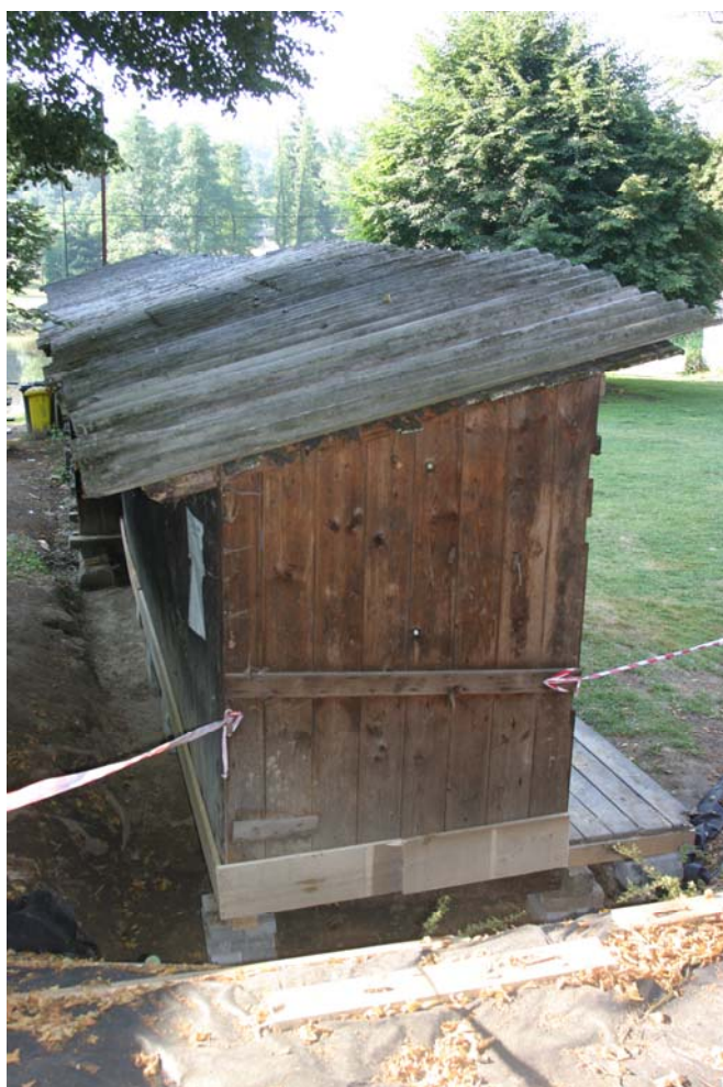
Kabiny jsou podezděny
