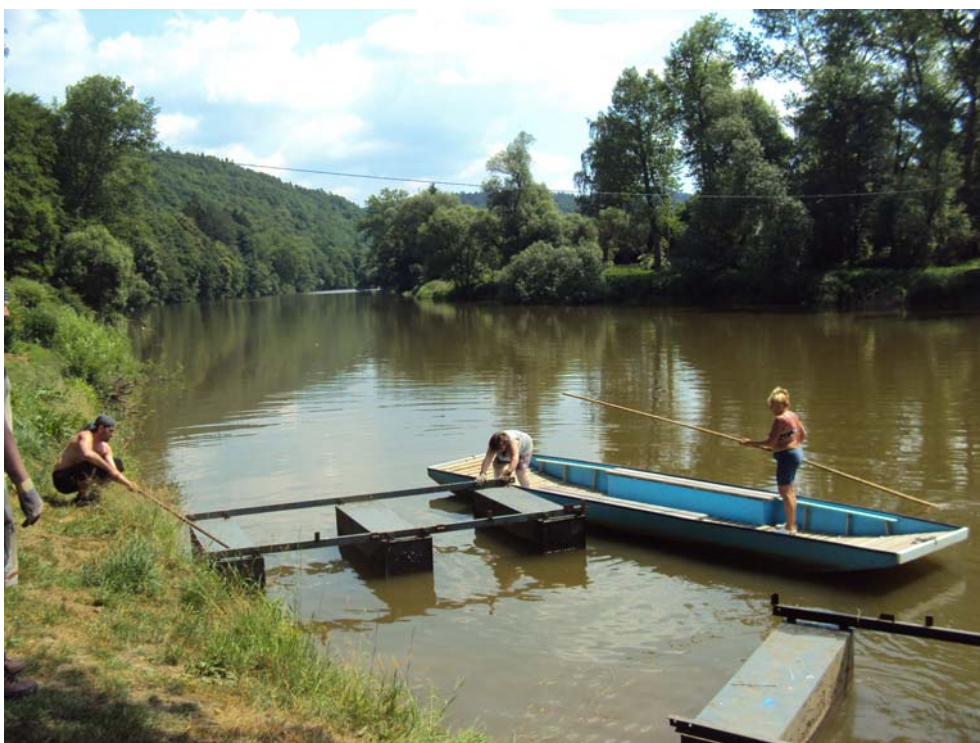
Plováky je na vodě nutno navzájem spojit
