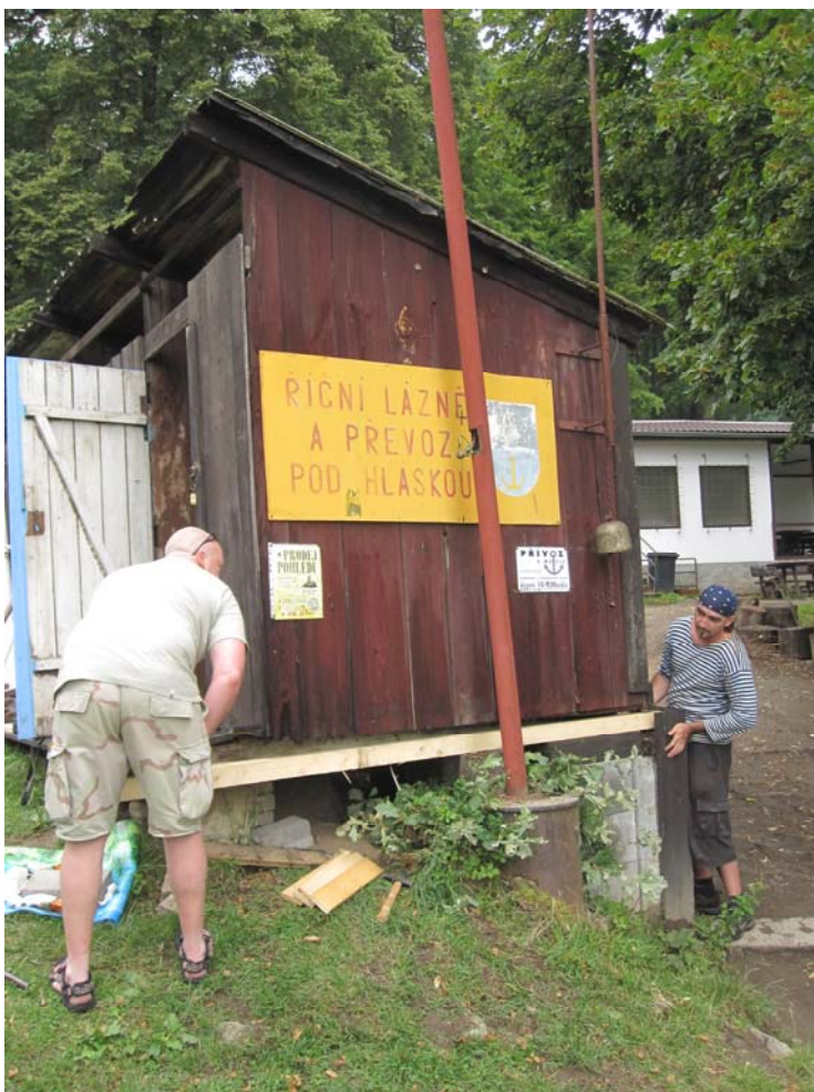
Oprava dřevěného roštu kabin na jejich konci
