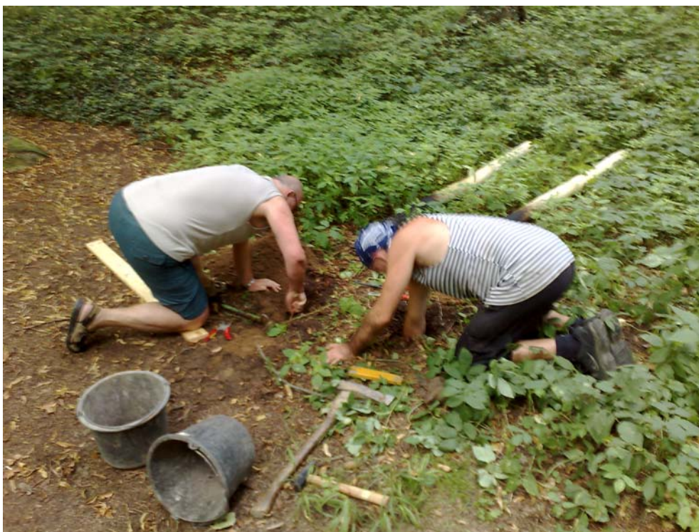
Hloubení sloupových jam pro vertikální konstrukci informačního panelu
