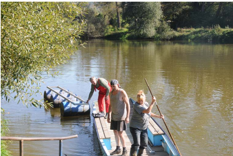
Splavení jednotlivých částí konstrukce pontonu po vodě
