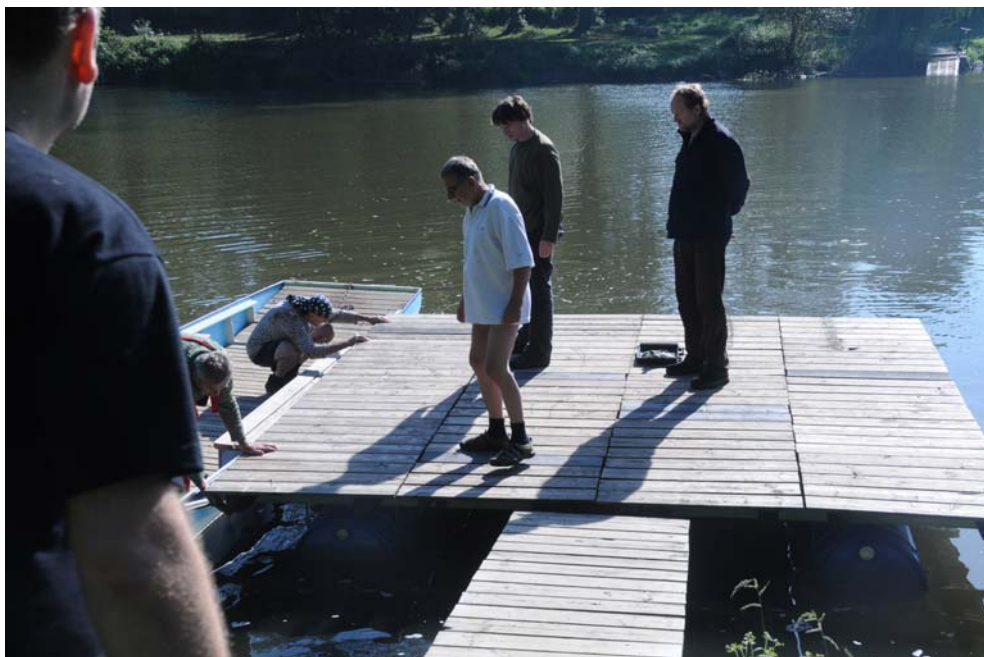
Demontáž podlážek vorku od jeho konstrukce
