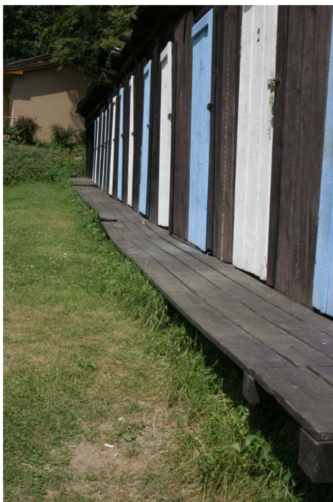
Opraveny byly některé trámy nesoucí ochoz kabin i prohnutá či prasklá prkna ochozu
