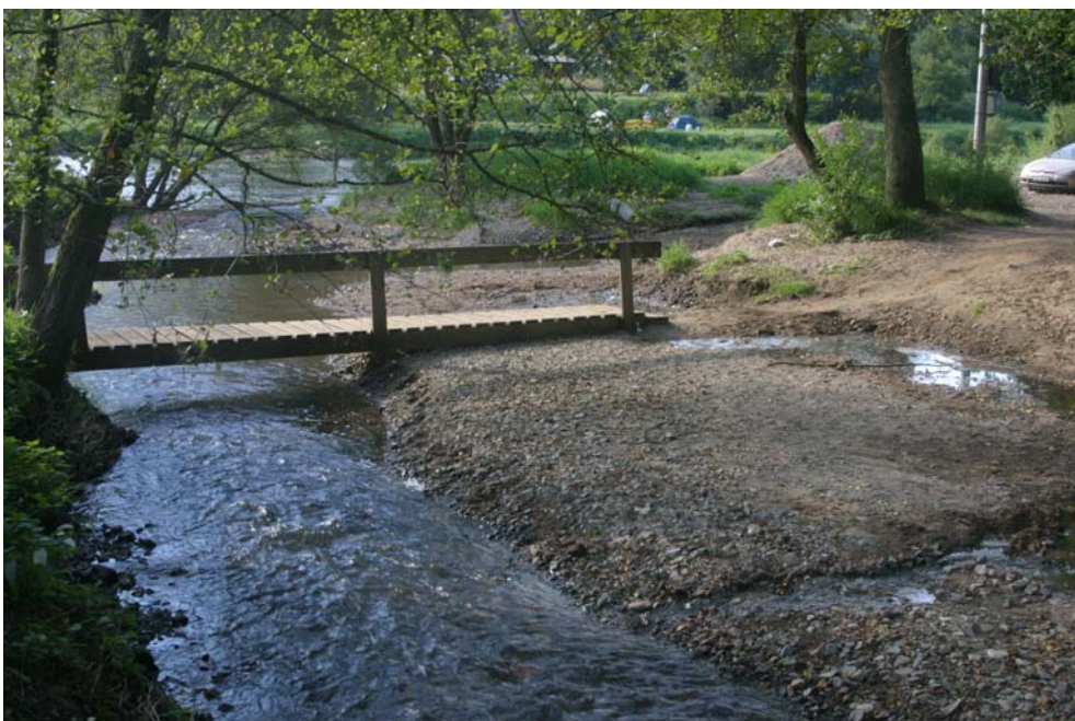
Lávka přes Mnichovku byla povodněmi několikrát smetena a po rozšíření koryta jí chybí téměř čtyři metry
