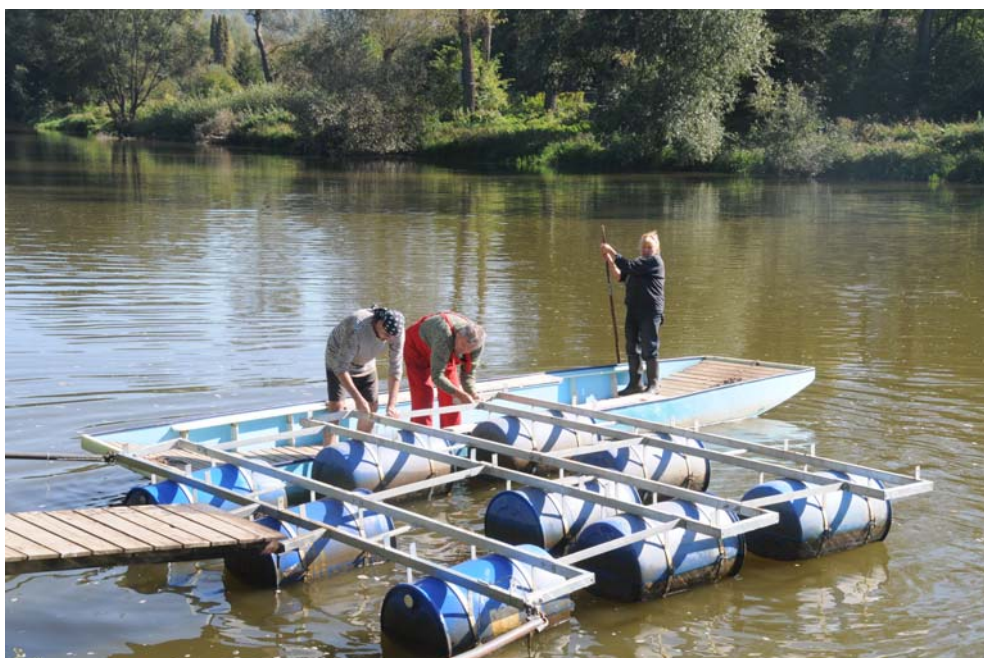
Nová lehká konstrukce pontonu je složena z většího množství částí
