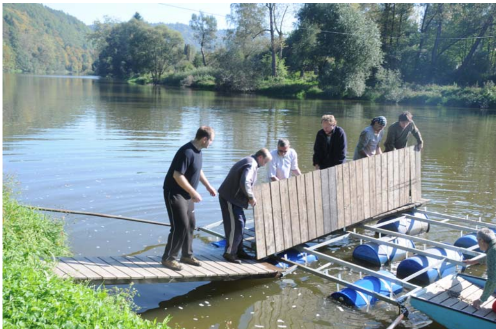
Postupně odhalujeme konstrukci pontonu z plastových barelů
