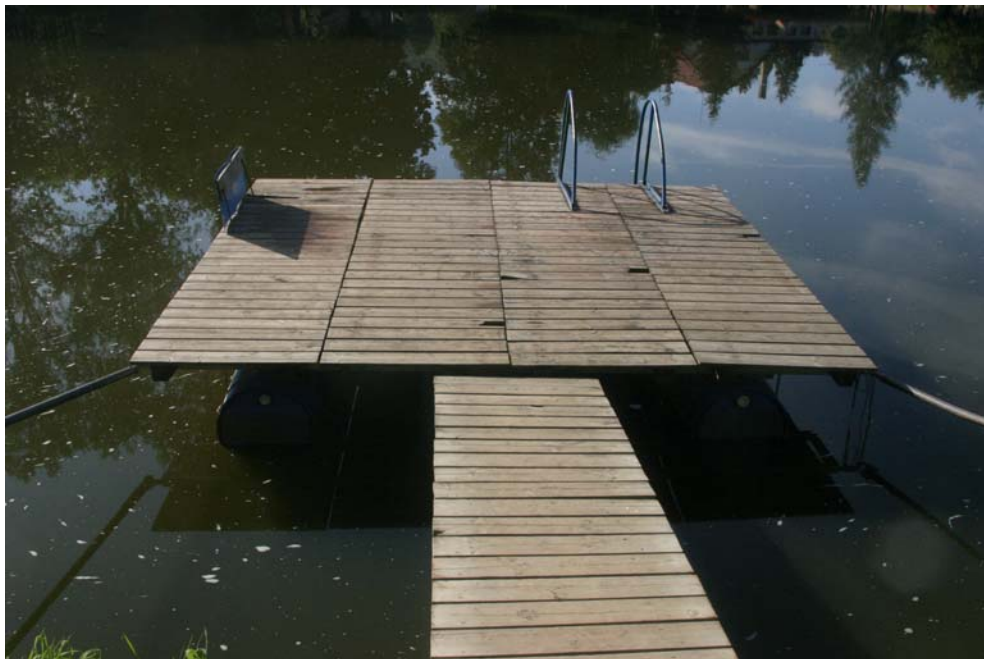
Nová konstrukce pontonu, ale podlážky ještě staré
