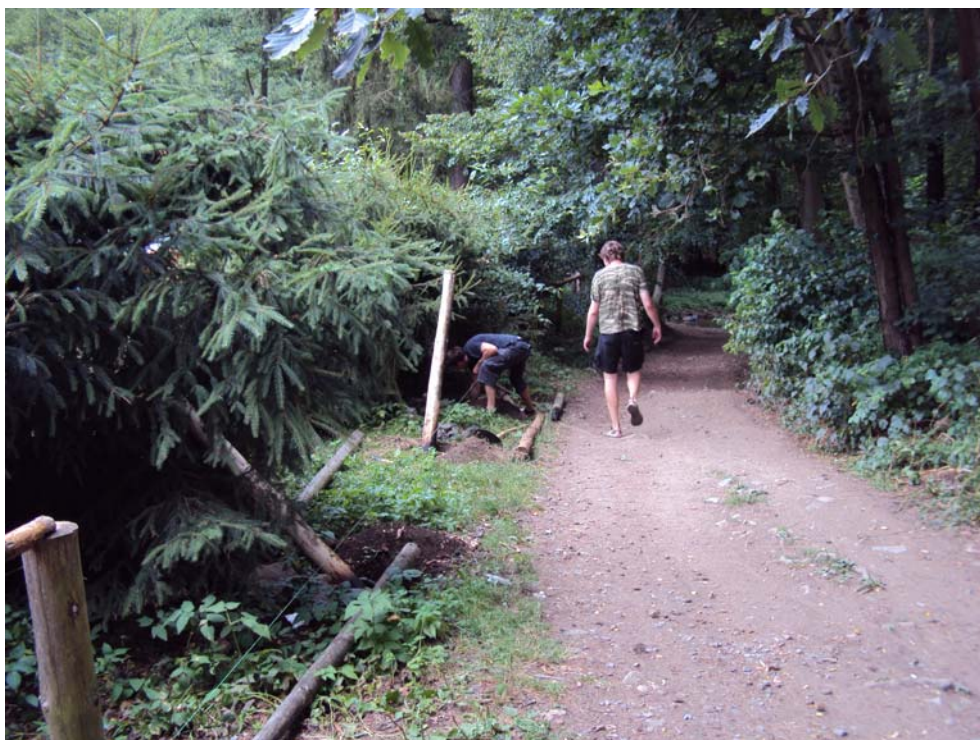
Podél přístupové cesty k Baštírně některé stojky již uhnily a bylo nutno přistoupit k výměně
