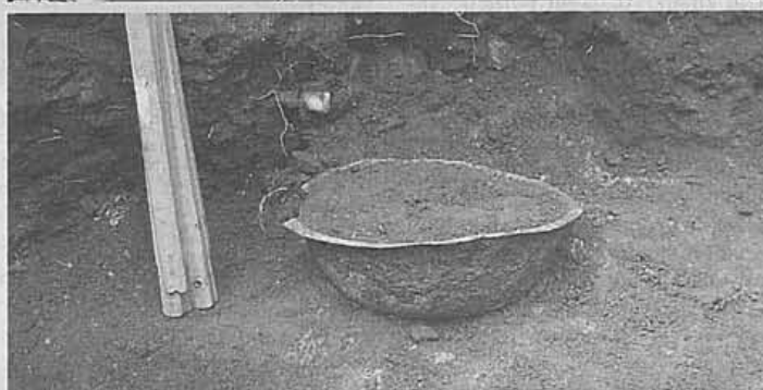
Vykopávky končí, zanedlouho se rozběhne stavba bytového domu Repro LN
