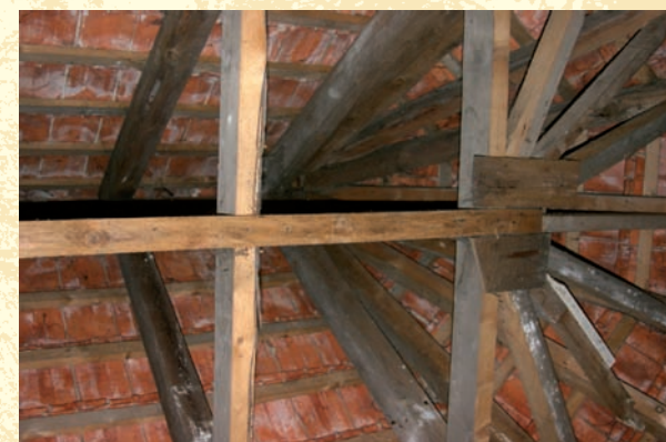
Pohled do krovu kaple.
