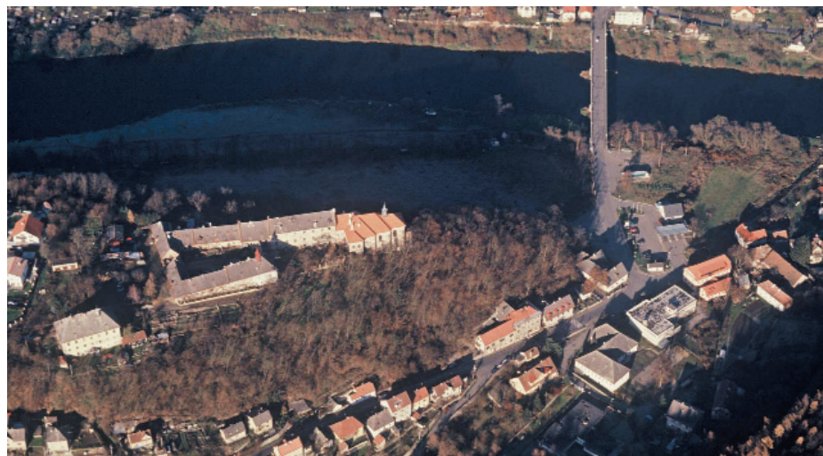
Letecký pohled na hrad Nižbor nad tokem Berounky. V popředí vpravo se nacházelo zaniklé druhé palácové křídlo situované paralelně s dochovaným severním křídlem s kaplí
