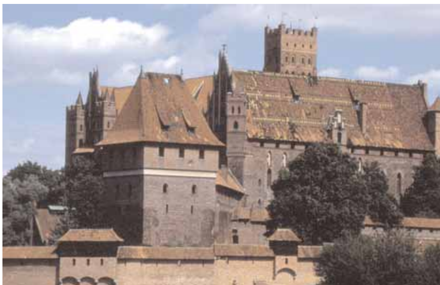
Střechy středověkého hradu Malbork (severní Polsko) byly zdobeny obrazci, tvořenými barevně glazovanými pálenými střešními taškami a prejzy
