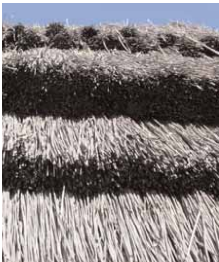
Rákosová střešní krytina
